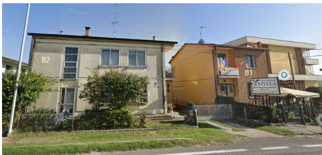
Immagine 13: Fronte di B1 e B2 su Via Faentina.
