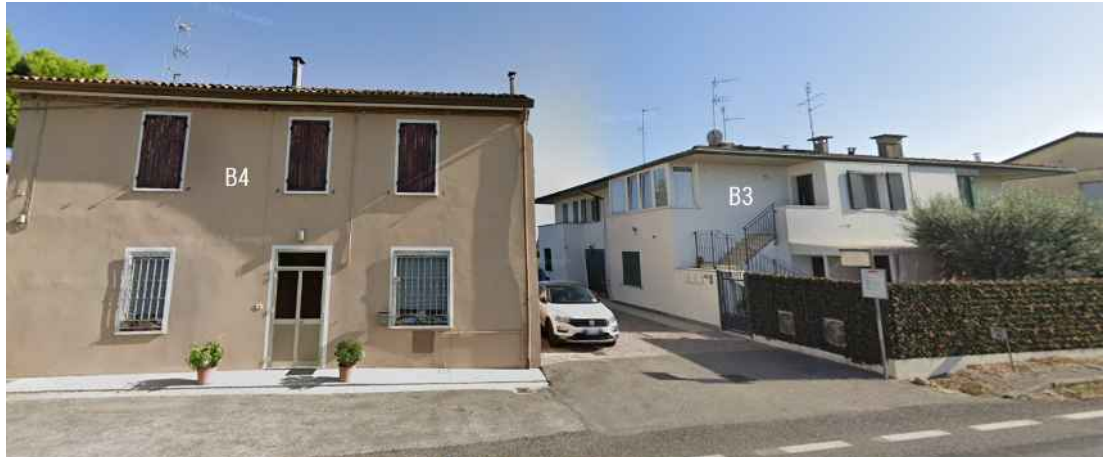
Immagine 14: Fronte di B3 e B4 su Via Faentina.
