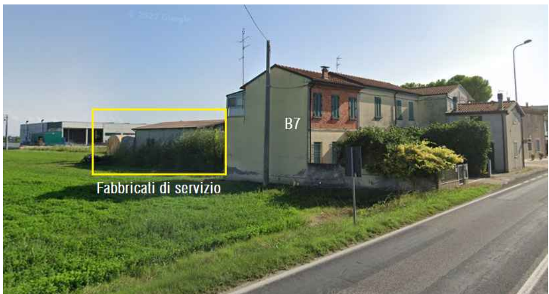
Immagine 16: Fabbricati di servizio sul retro di B5, B6 e B7.
